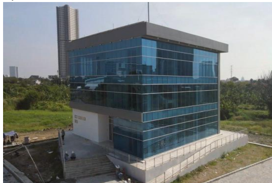
Gambar 1: Progres Gedung ICT Robotik
